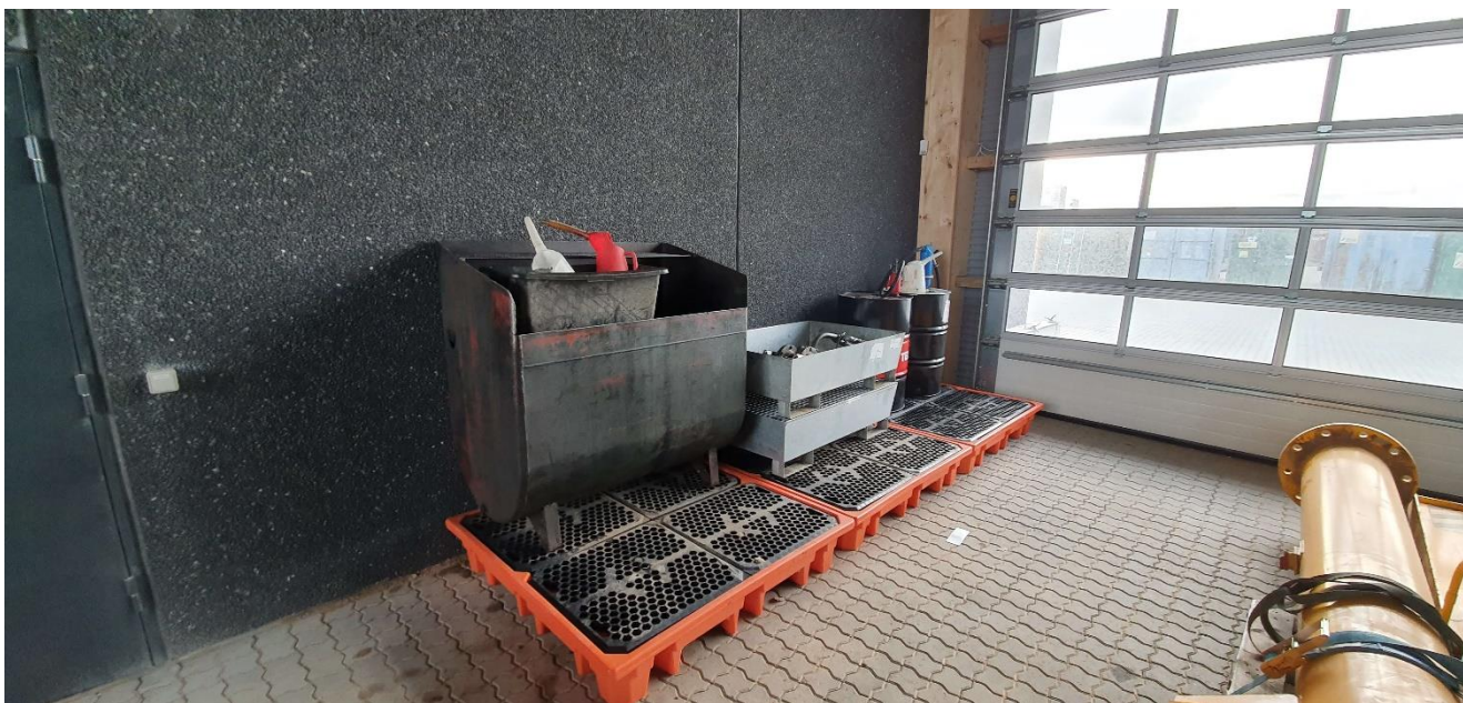
Spildolie opbevares i tank, som er opstillet på spildsikring.
