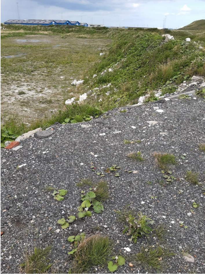
Billede 5 – Knust asfalt ved tippen ud til nordligste enhed
