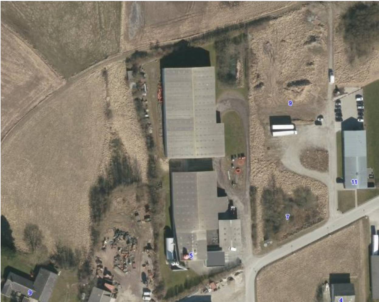
Luftfoto af Tranebjerg Varmeværk
