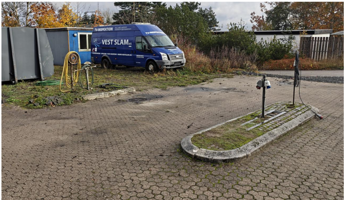
Vaskeplads – uden afgrænsning i forhold til regnvand fra pladsen omkring.
