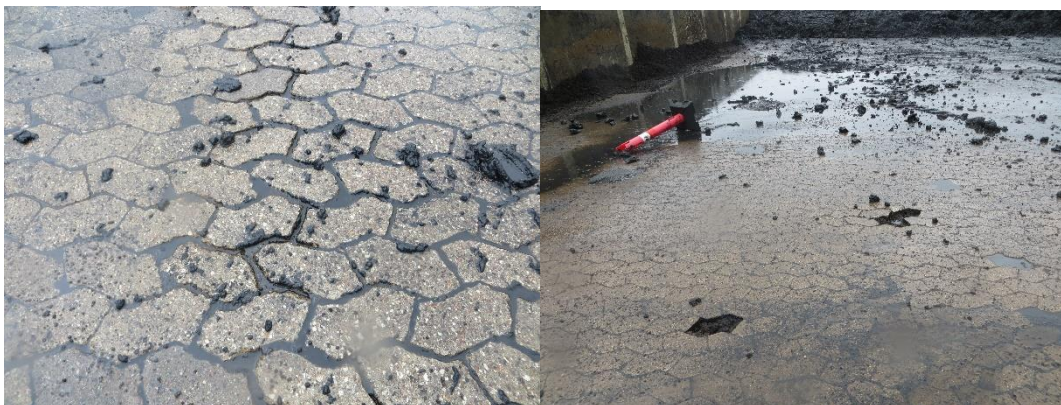
Belægningen på slamlageret.
