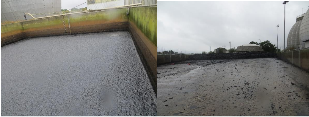
Tv; Slam fra egne rådnetanke. Th; Slamlager til tørslam fra eksterne.
