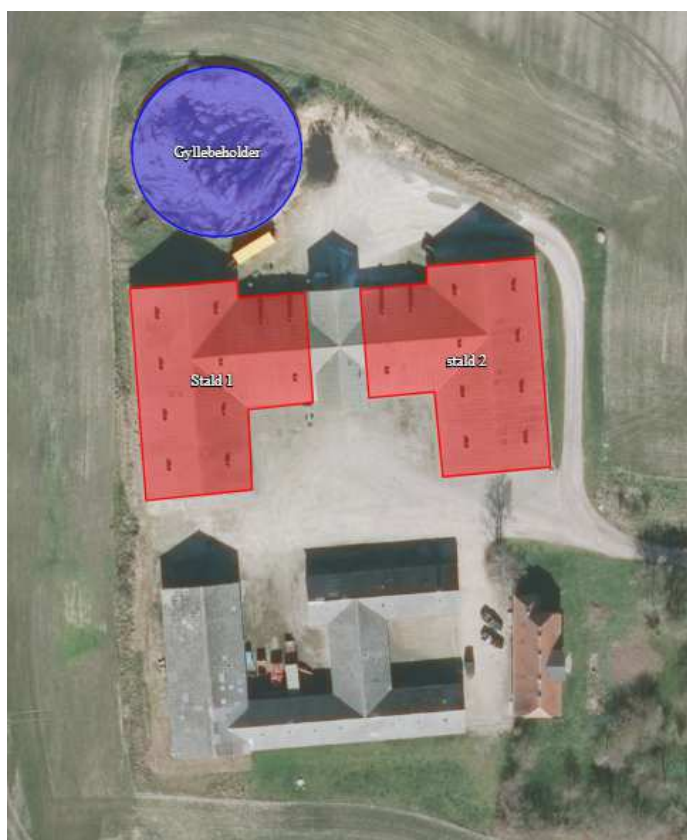
Figur 1. Staldanlæg på Eskemosevej 1A
