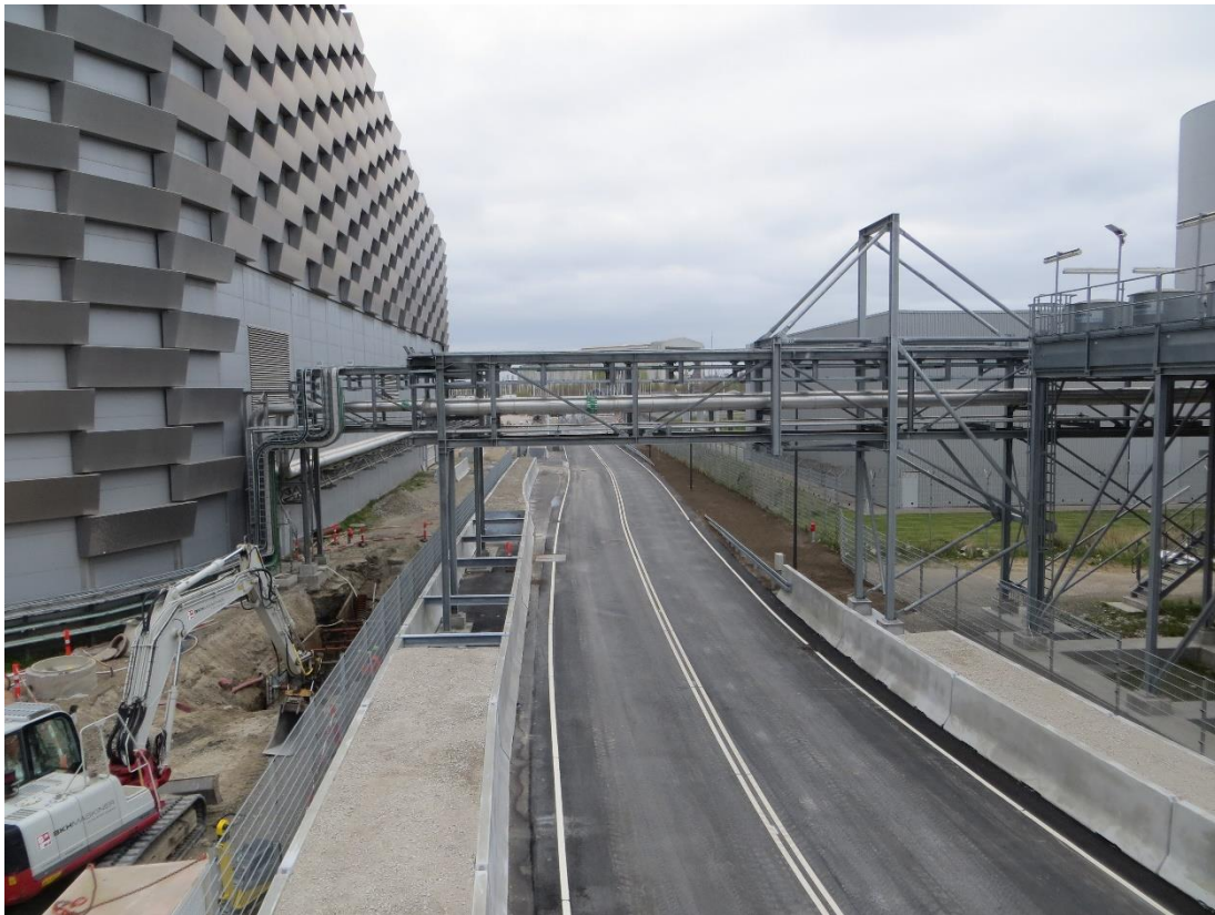
Vejen til Lynetteholmen –betonsikring mod bygning t.v. og tankgård t.h.
