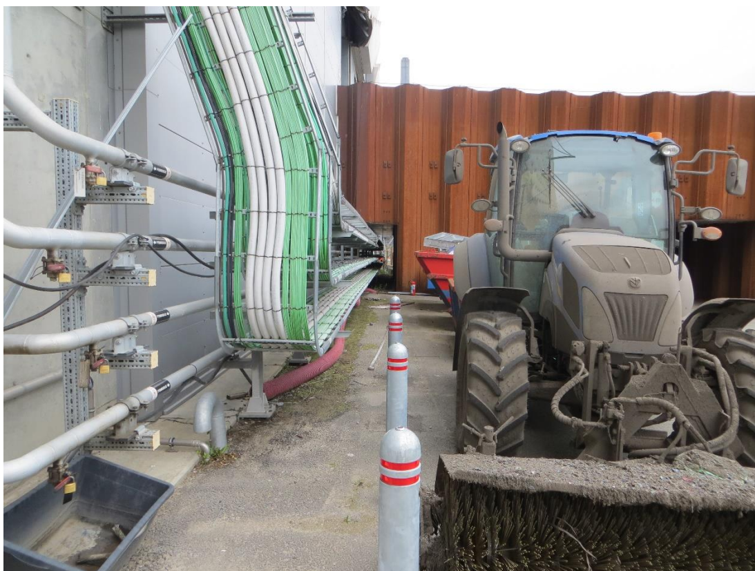
Sikringen er dog ikke ført helt igennem. Der er ikke sikret ved de sidste 6-7 meter hvor der var opstillet maskiner og afsat containere.
