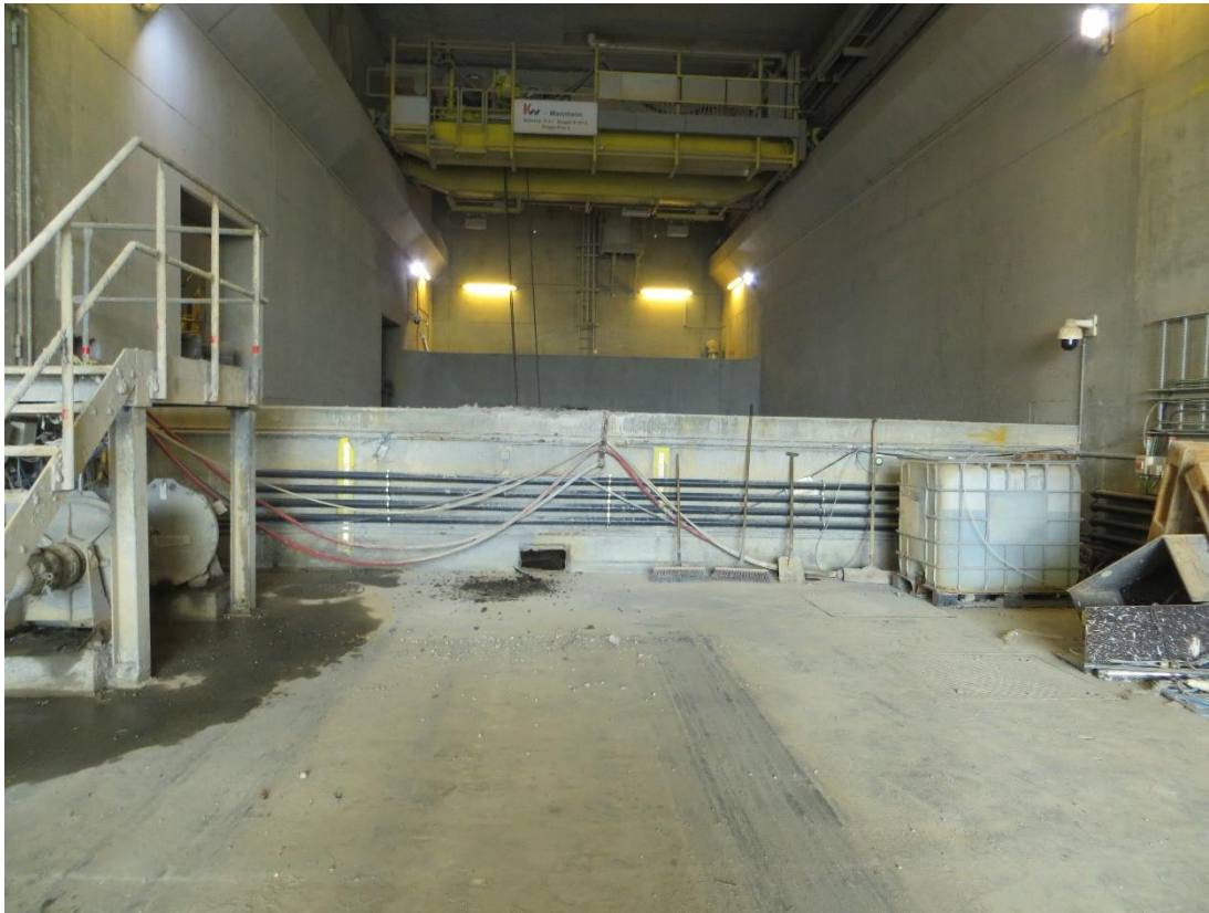
Slaggeporten – slaggeoplaget er bag muren – palle med eddikesyre t.h.
