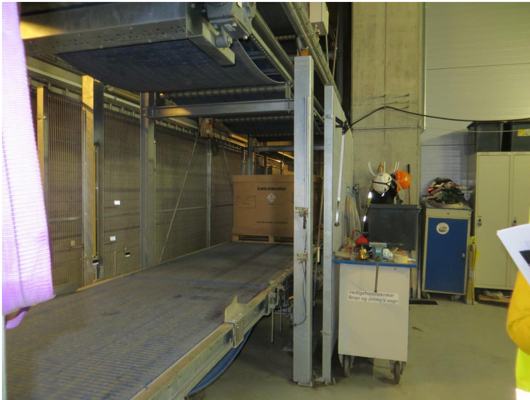
Båndet fører pallen direkte til ovnen via specialindfyring
