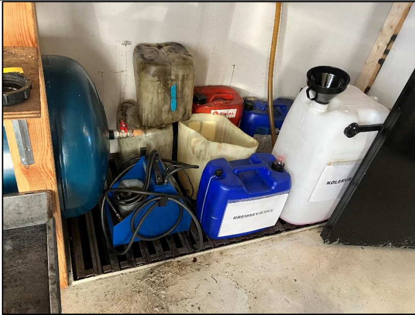
Opbevaring i olierum uden afløb på rist over opsamling
