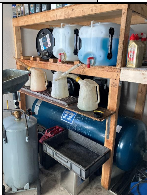
Opbevaring i olierum uden afløb
