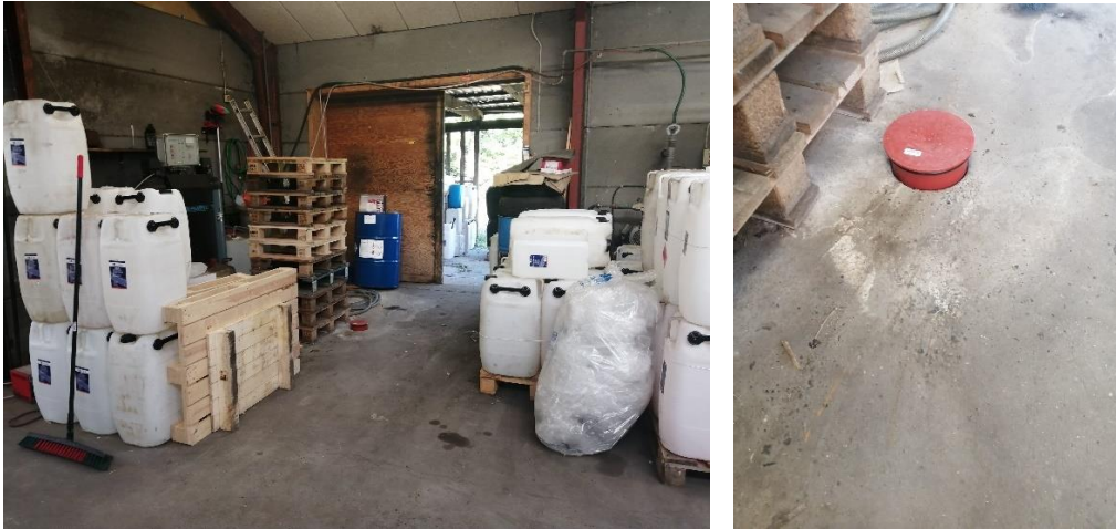
Billede 16. Afropning af afløb i lagerum billede fra prioriteret tilsyn 2021.
