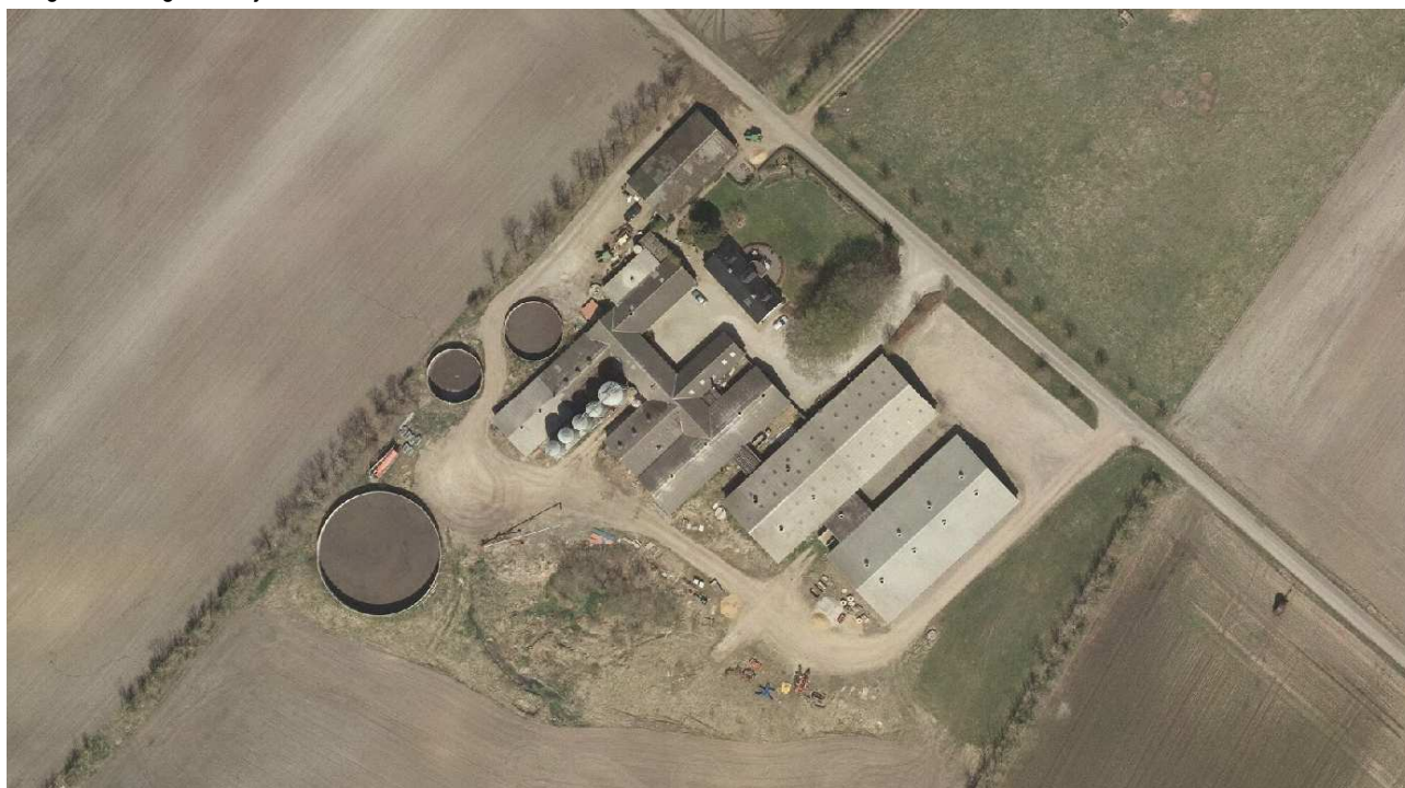
Bilag 1: Oversigt over ejendommen.
