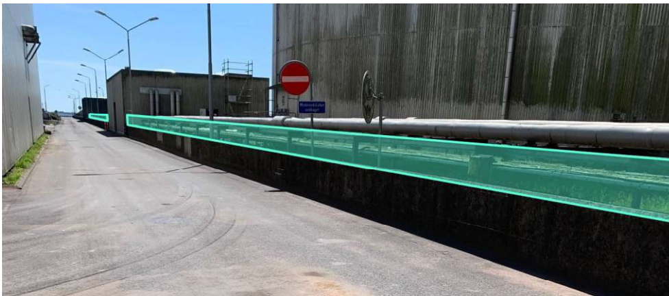
Figur 2 Forhøjelse af eksisterende tankgårdsmur
