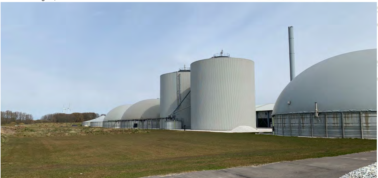
Billedet er taget vest for anlæggets indleveringstanke (i retning syd mod nord) og viser bagsiden af anlægget. Længst til
