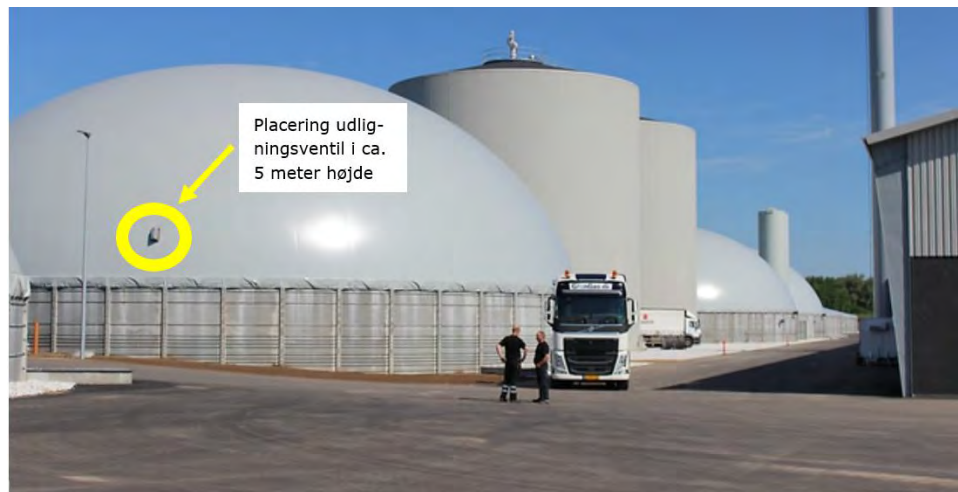
Figur 2.1: Placering luft-udligningsventil på tanke med membranoverdækning.
