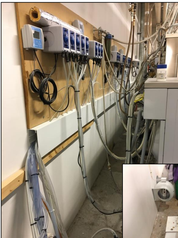
Foto til venstre viser installationen af den automatiske sæbedosering. Den er installeret på alle vaskemaskiner siden sidste års tilsyn.
