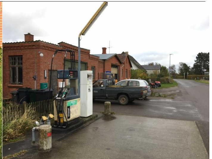
12. Tankplads ud mod Herredsvej
