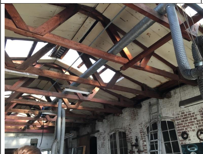
3. Udsugning etableret på værkstedet
