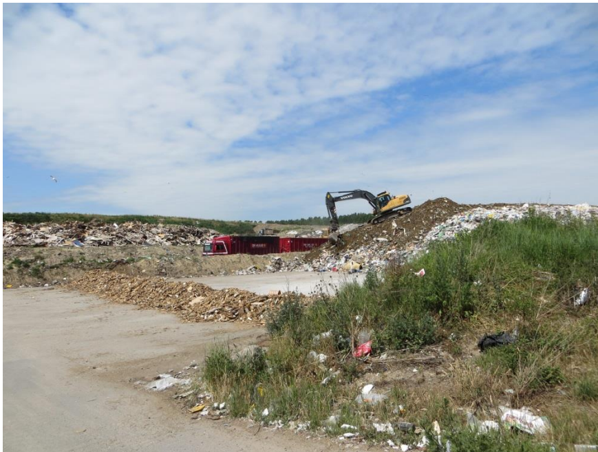
Celle 3: Småt brændbart afdækkes med jord.
