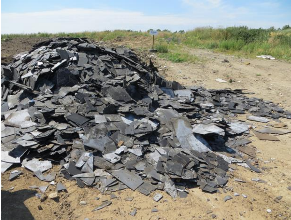
Asbestdeponering i celle 4 (syd), inden daglig afdækning.
