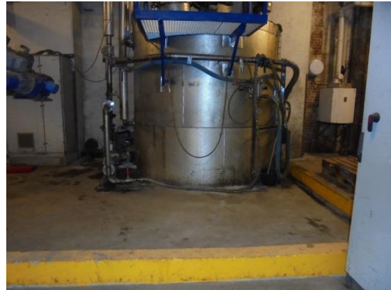
Ved tilbagepumpning af olie fra udsugningen over presserne, placeres palletanken på pallerne til højre i billedet.
