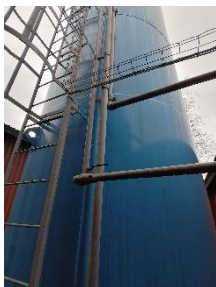
Blå mellemtank til transformerolie
