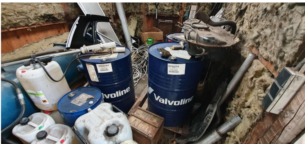
Spildolie m.m. opbevares i skur uden spildsikring.
