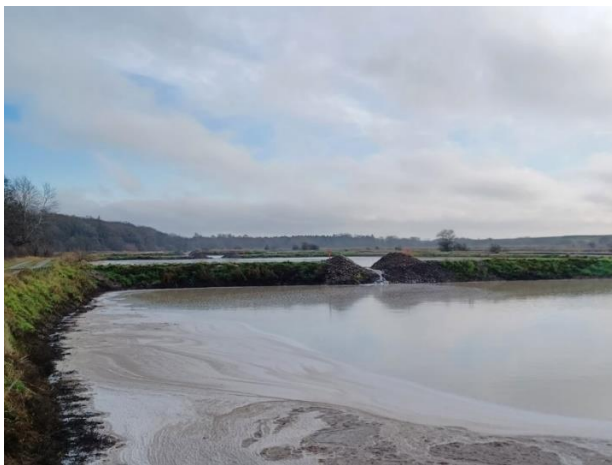
Foto 3: Sedimentationsbassin 6 (forrest), modtog vand fra bassin 5 (bagved), som igen modtog vand fra bassin 4 osv. Bemærk skum, og højdeforskel på bassinernes vandspejl. Fotoet blev taget mod øst.
