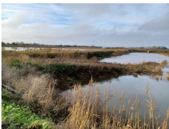
Foto 6: Rampe i sedimentationsbassin 42, som anvendes til kørsel ved opgravning af sedimenteret materiale fra bassinet.
