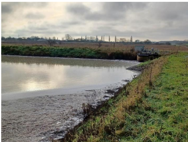
Foto 4: Pumpe i sydvestlige hjørne af bassin 6 – vand pumpes til klaringsbassin 50.
