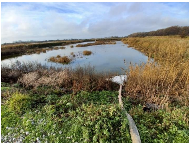
Foto 5: Regnvand fra bassin 43 ledes til bassin 42 på billedet via slange over vej.
