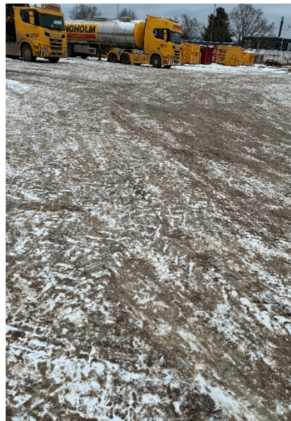
6. Holdeplads med utæt belægning
