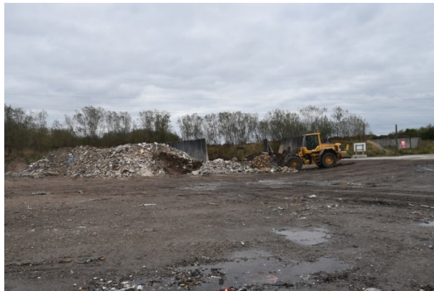
Beton og tegl til nedknusning
