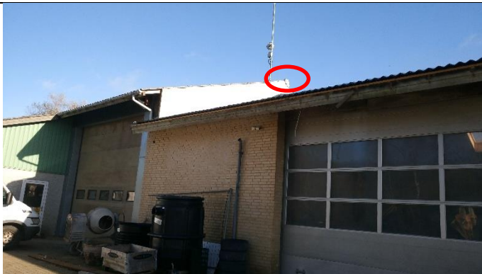
Billede nr. 1: Udsugningsanlæg, svejsning (2021)
