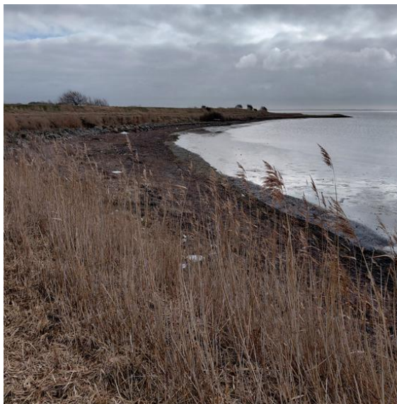
Foto 4. Stensætning langs vandkanten til beskyttelse mod erosion.
