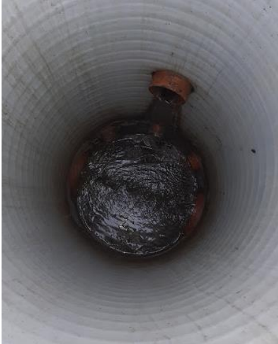
Figur 15. Forurening i brønd 2 på figur 12.
