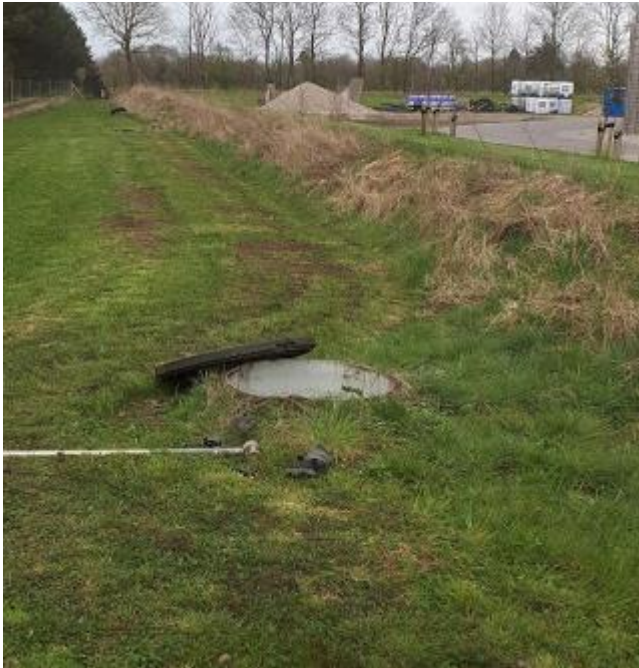
Figur 13. Brønde nord for Outrup Biogas.
