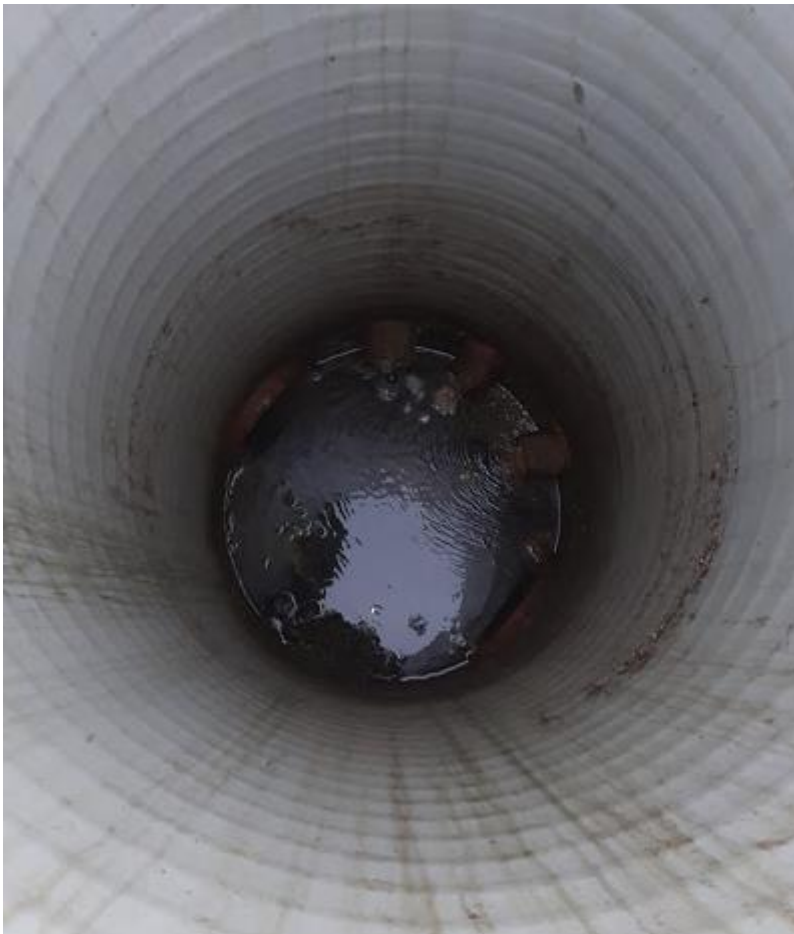
Figur 14. Forurening i brønd 1 på figur 12.
