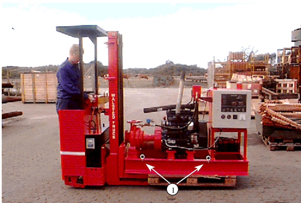
Figur 1: Transport af sprinkleranlæg, 1) Løfteøjer
