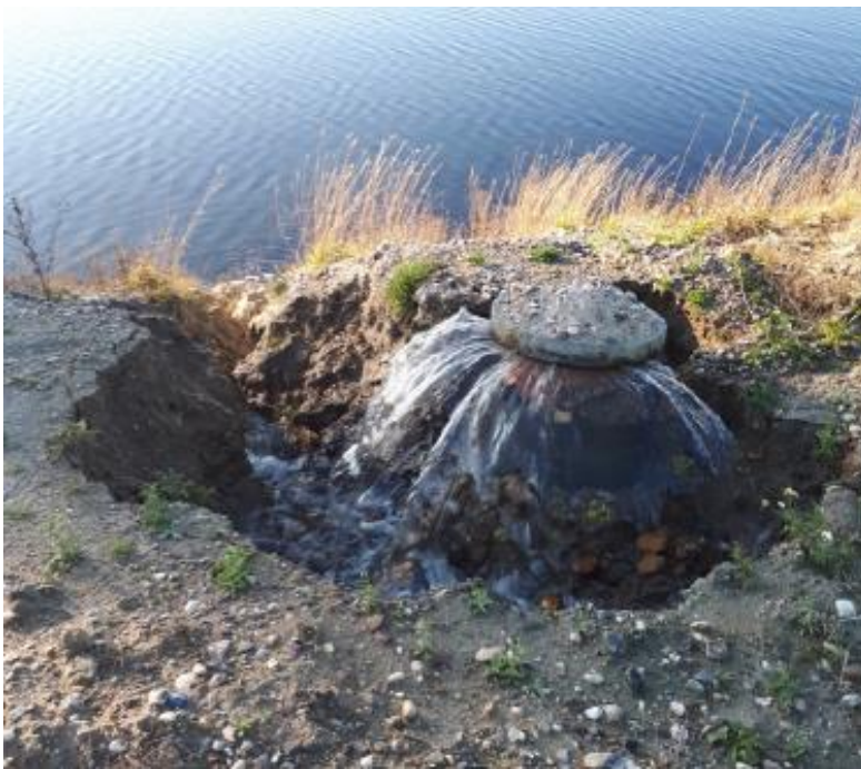
Foto 6. Overløb af slukningsvand fra kuloplag til bassin 24
