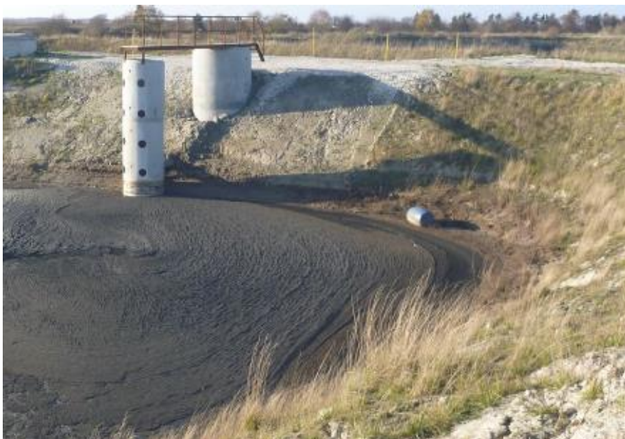
Foto 2. Plastiktønde i bassin 24.
