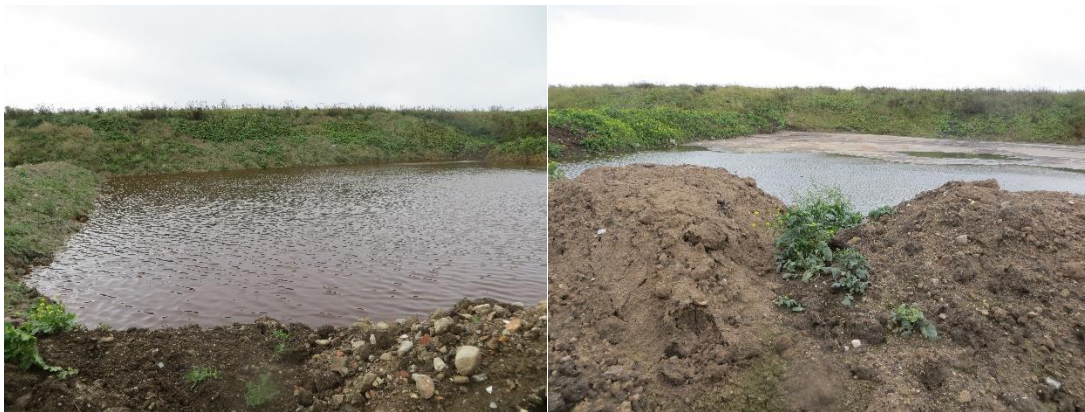
2 af lagunerne til afvanding af eget slam på gammel plads.
