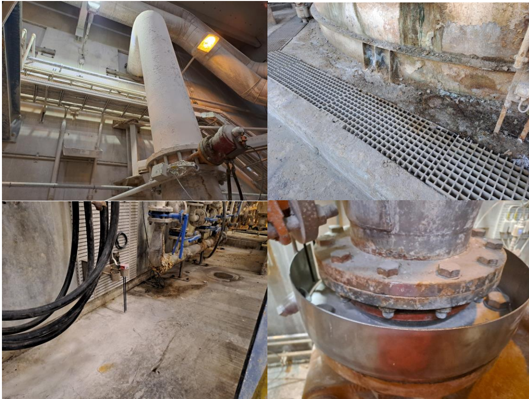
Figur 4: Nye tiltag til forhindring af spild af scrubbervæske
