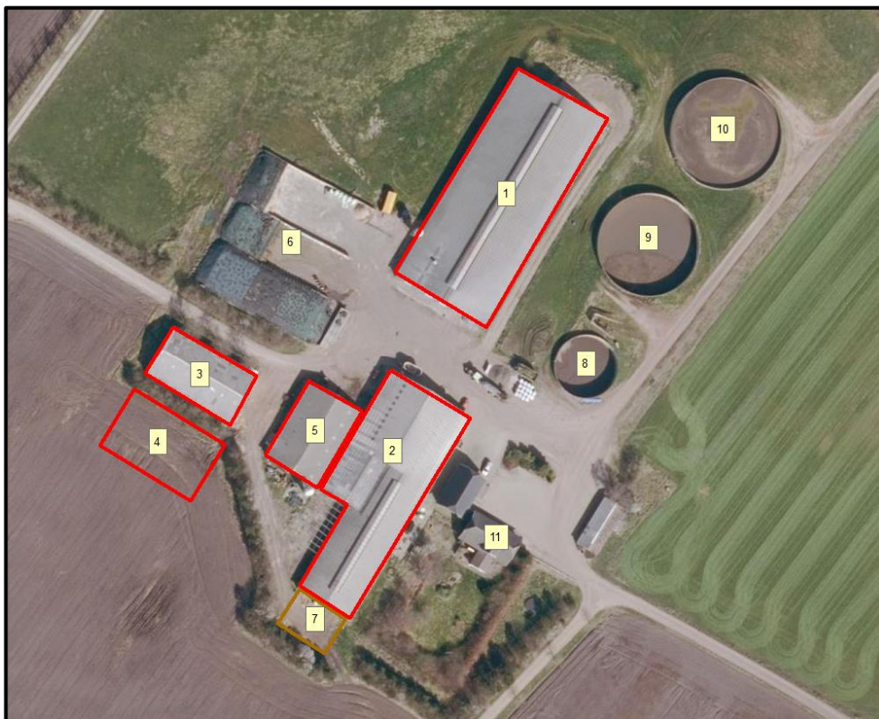
Figur 4. Oversigt over husdyrbrugets bygninger.
