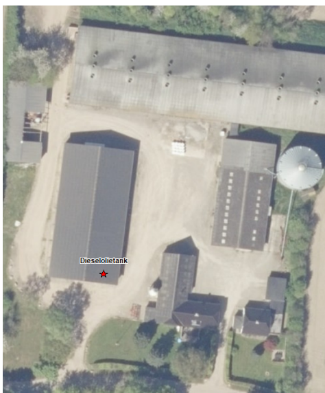
Figur 13: Placering og olietank på ejendommen
