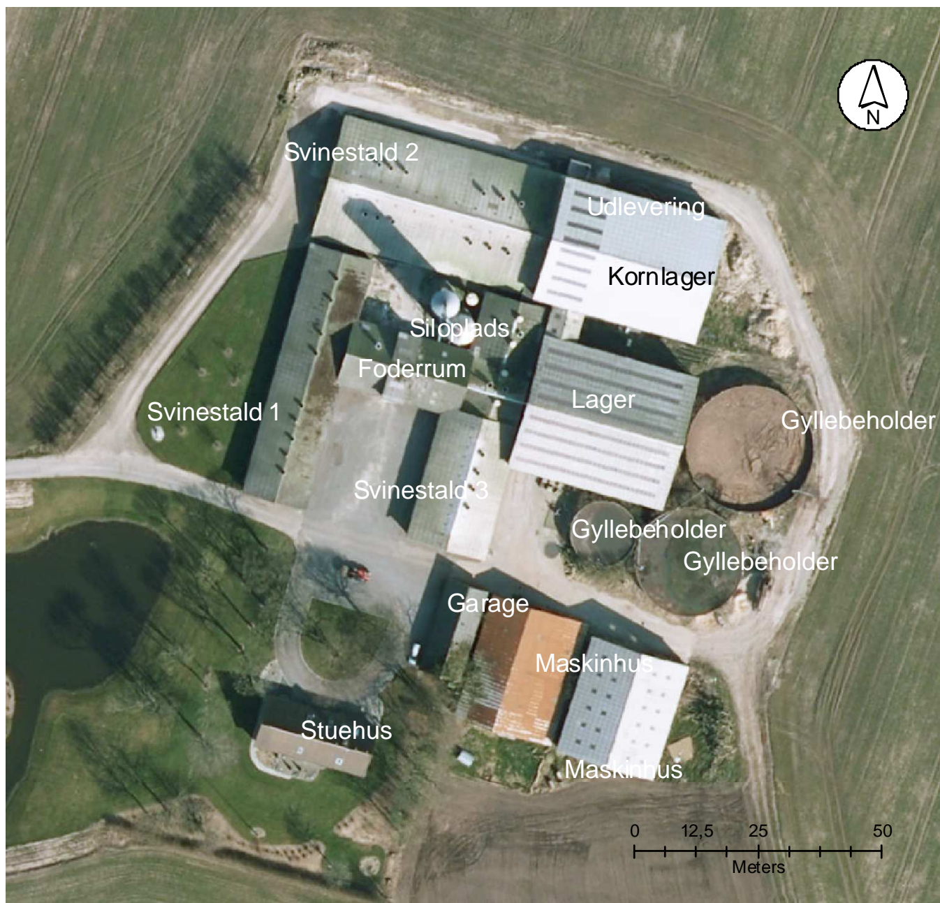
Oversigtskort af ejendommen fra miljøgodkendelse i 2009. Der er ikke sket ændringer i bygningsanvendelsen. De to østlige gyllebeholdere har i dag fast overdækning.
