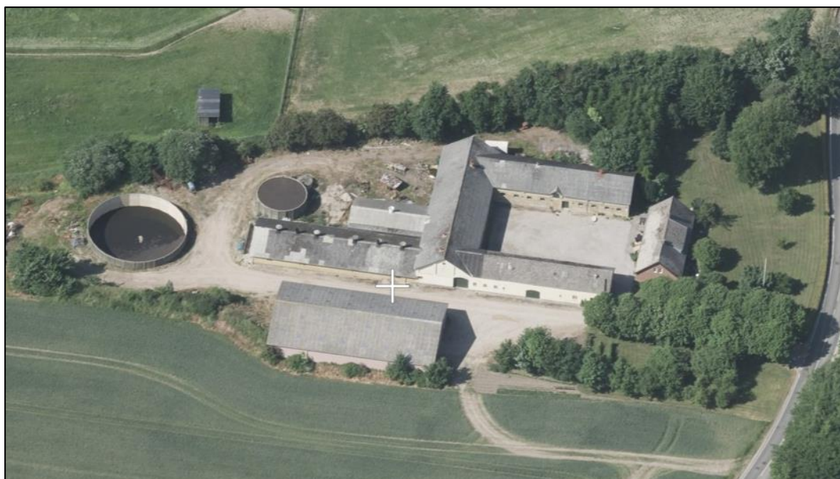
Ejendommen på Dærupvej 72, 5620 Glamsbjerg (luftfoto 2021)
