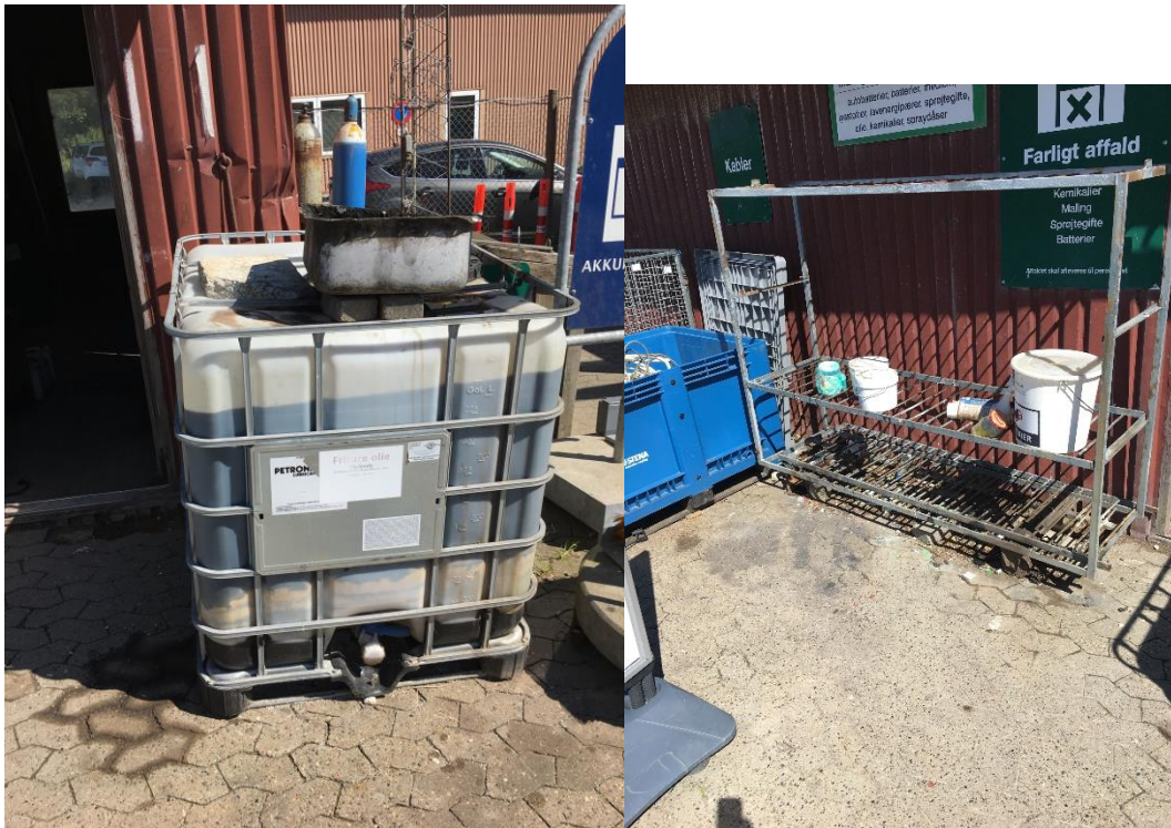
Figur 4 tv. 1.000 L palletank til spildolie. Th. reol til indlevering af farligt affald på genbrugspladsen. Er placeret direkte oven på en FS-stenbelægning.
