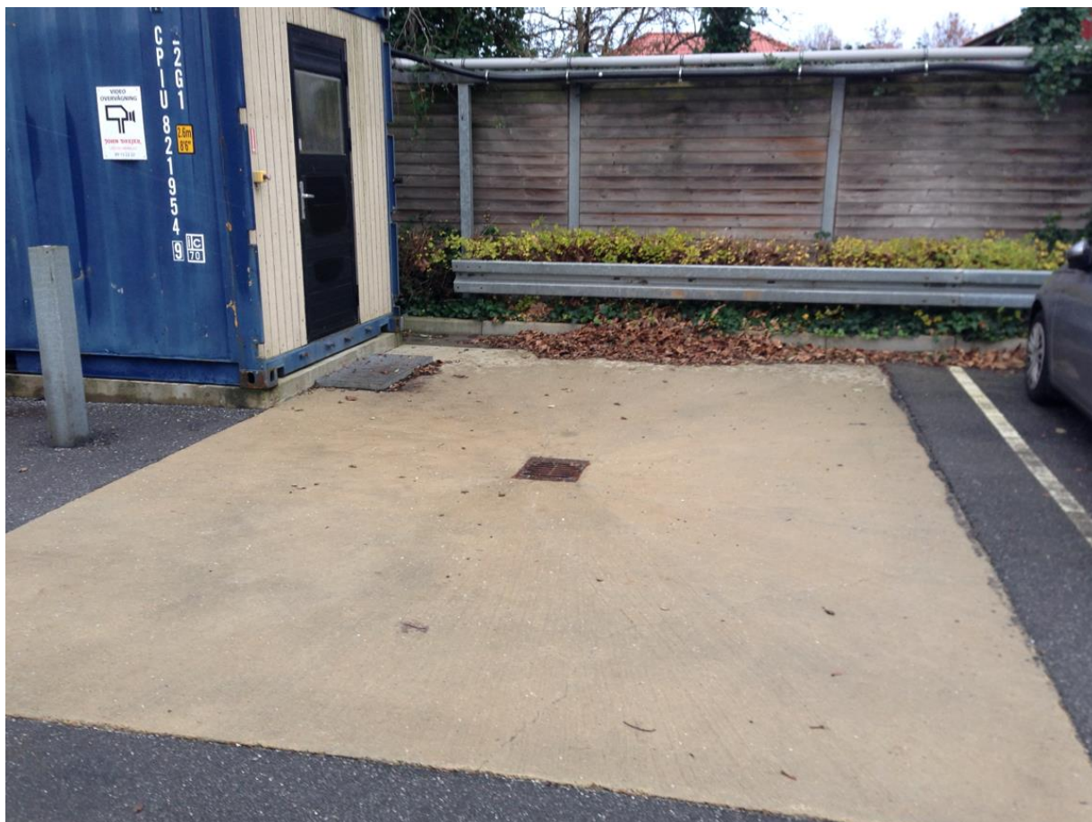
Fig. 2 Udendørs påfyldningsplads ud for container med olietanke
