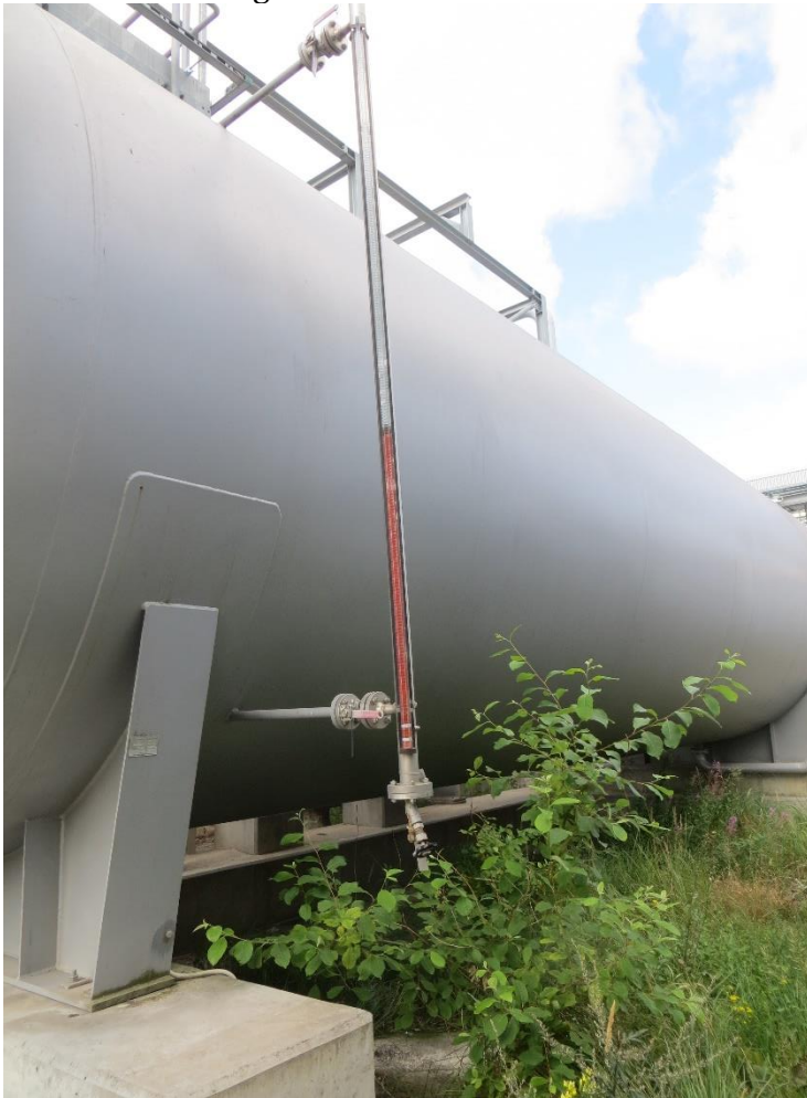
80 m3 propylentank uden tankgård og opsamling af spild
