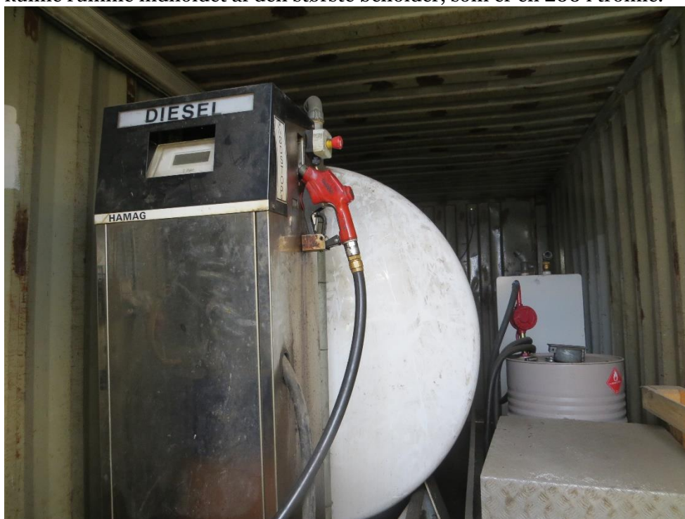
Olietank i container nær port 11
