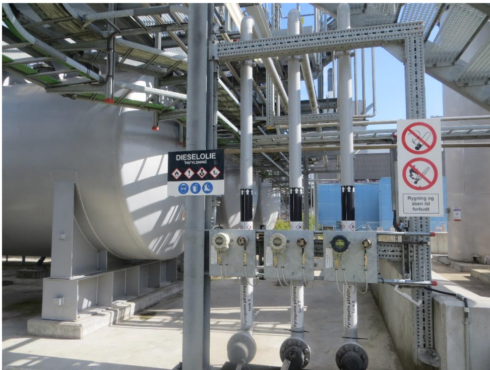
3 olietanke med tankningssted Fælles tankgrav.
