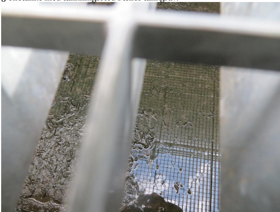
Slam i bunden af afløbsbrønden i olietankgraven
