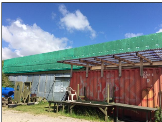
Foto 1. HP 16. Eksisterende skillevæg hævet 4,25 m over standplads, bane nr. 14-15 IPSSC baner
