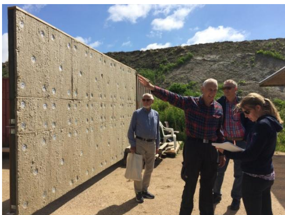
Foto 3. HP 17. 2,5 meter høj skærm bag standplads. Bane nr. 16 IPSC baner
