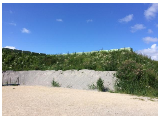
Foto 2. HP 17. sidevold hæves til 5 meter over baneplan. Bane nr. 16 IPSC baner
