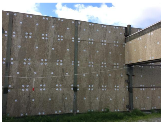
Foto 4. HP 20. højre sidevæg på alle baner er forhøjet ved pistolbanerne til 5 meter over baneplan.
