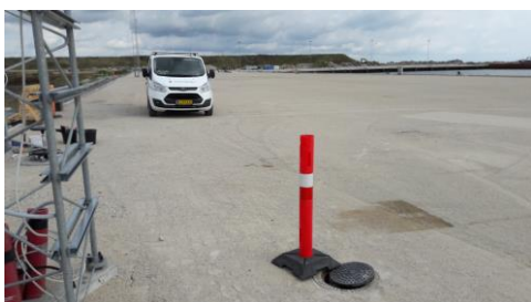
Foto 7: Monitoringsboring M19 med køredæksel til venstre og med lås og mærkning til højre.
