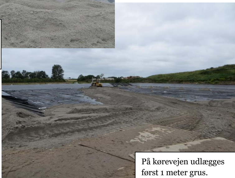
Drængrus udlægges i 0,5 meters tykkelse ovenpå plastmembranen.
