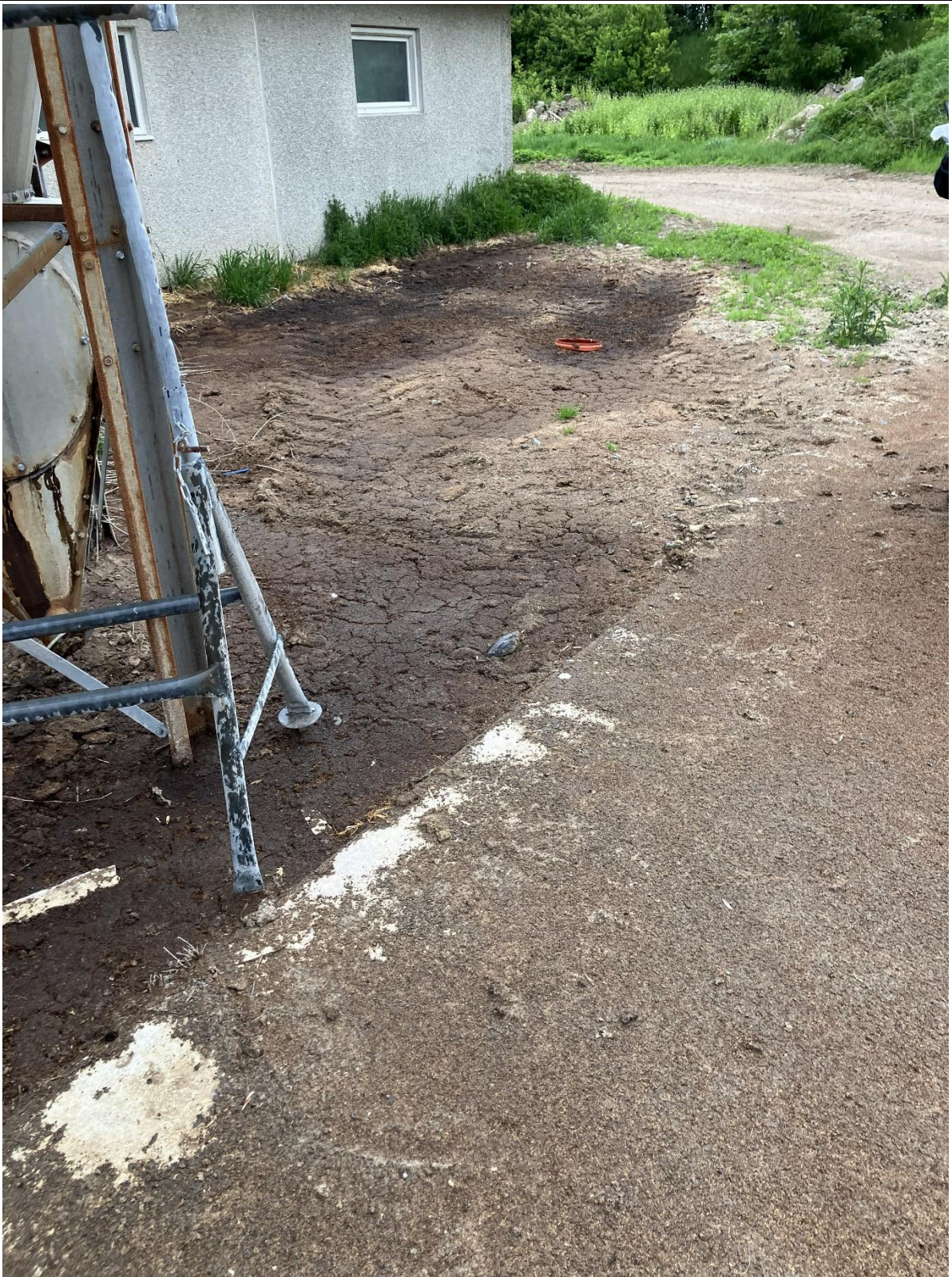
Øvrige bemærkninger, manglende afløb på vaskeplads
