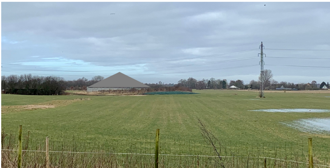
Indsigt fra Sverkilstrupvej 52, set fra sydøst, med overdækning af stor gyllebeholder
