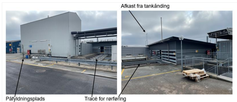
Figur 5 Foto af eksisterende påfyldningsplads, rørføring, afkast og eksisterende påfyldningsplads
