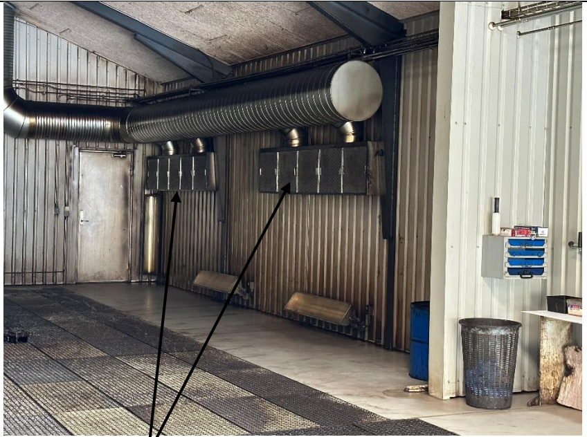
Billede nr. 7: Metalfiltre ved undervognsbehandlingen. (2023)
