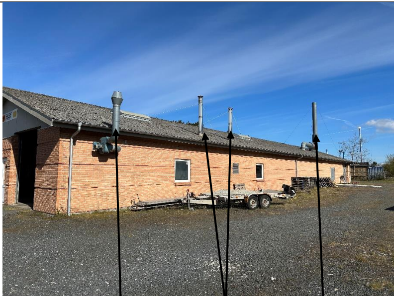
Billede nr. 5: Ved vaskeplads, 2 stk. fyringsanlæg, undervognsbehandling (2023)
