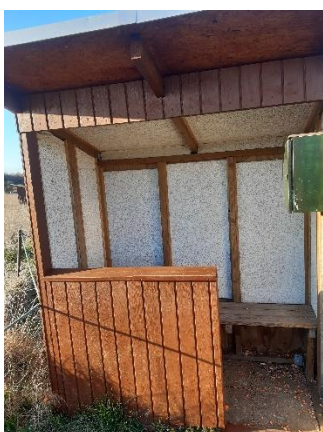
Billede 1. Isoleret skydehus
