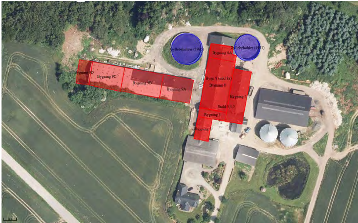
Figur 1. Åstruplundvej 9. Ejendommens indretning (stalde)
