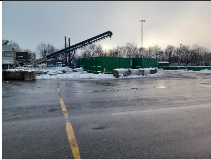
Foto 1: Oplagsplads ved den tidligere shredder. Nu er den til opstilling af containere og metal burer. Et stort hul i belægningen er markeret med signalbånd.
