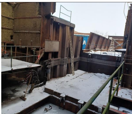
Foto 14: Shredderhus, hvor selve shredderen har været placeret. Der var vand/is udgravningen.
