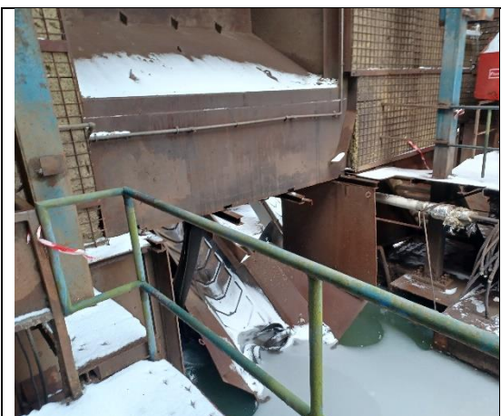
Foto 13: Shredderhus, hvor selve shredderen har været placeret. Der var vand/is udgravningen.
