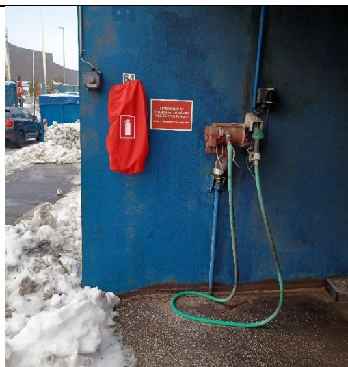
Foto 7: Område med nedgravet benzintank med ophængt tankpistol og befæstet areal. Benzintanken er ikke i drift.
