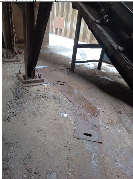
Foto 15: Rende, dækket med jernplader, til afledning af overfladevand til renselægget.
