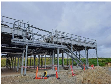
Figur 4 Kølegård til varmepumpe
