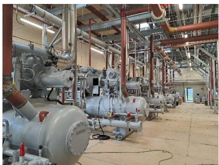
Figur 3 Kompressorrum - varmepumpe
