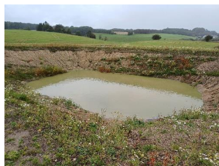
Figur 5 Forsinkelsesbassin (nedsivning) til almindeligt belastet overfaldevand
