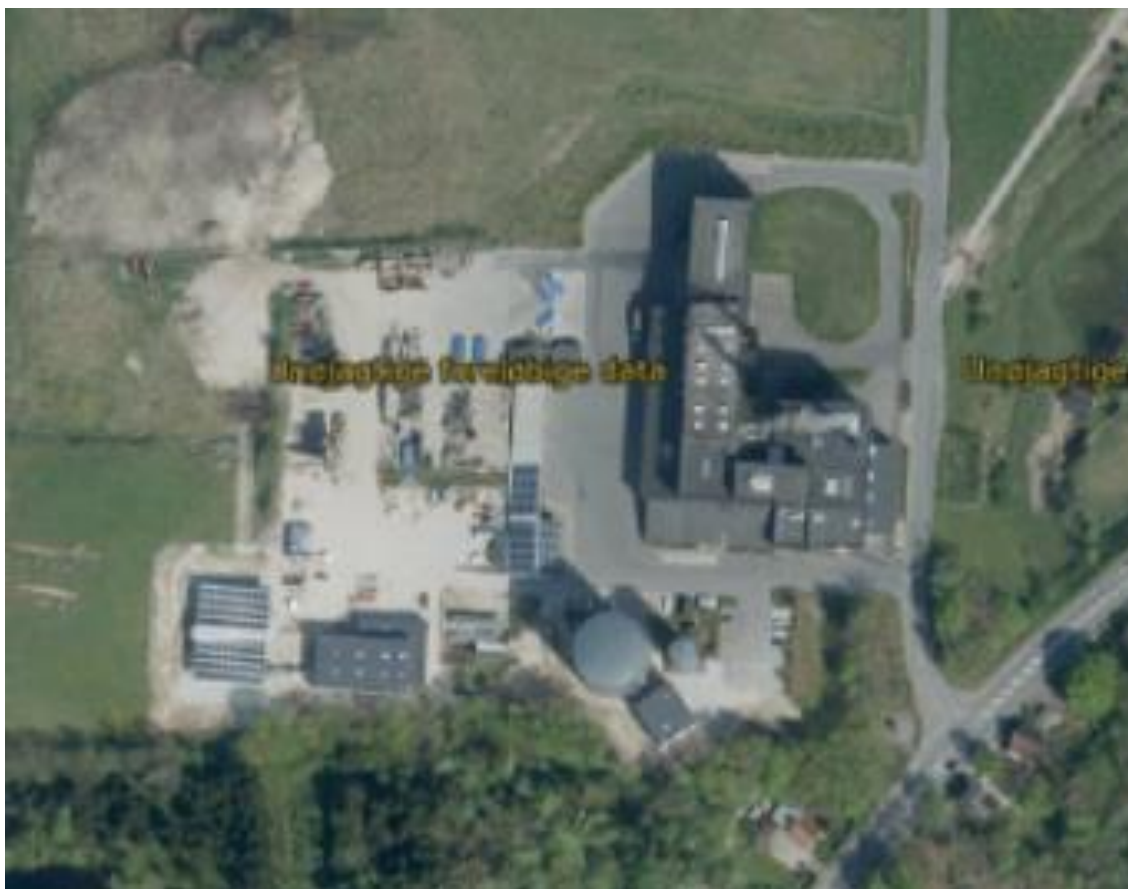
Figur 1 - Aars fjernvarme hvor de nye installationer er med : Ny og større akkumulerings tank, kølegård og luftvarmepumpe nederst til venstre.
