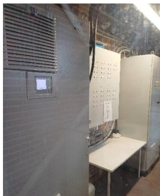
Figur 6 AMS måler kviksølv (nærmest) AMS måler for øvrige parametre (længst til højre)
