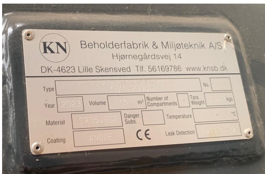
Foto 2 Tankmærkat fra dieselolietanken i hallen på Brolæggervænget 1
