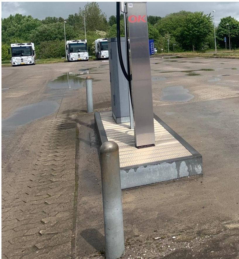
Foto 5 Belægning på påfyldningspladsen, som består af coloc sten (til venstre på foto).
