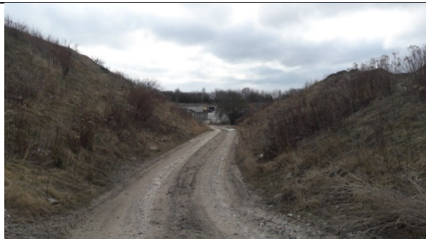
Billede 50. Nedkørsel mellem etape 1 og 2/3 mod S
