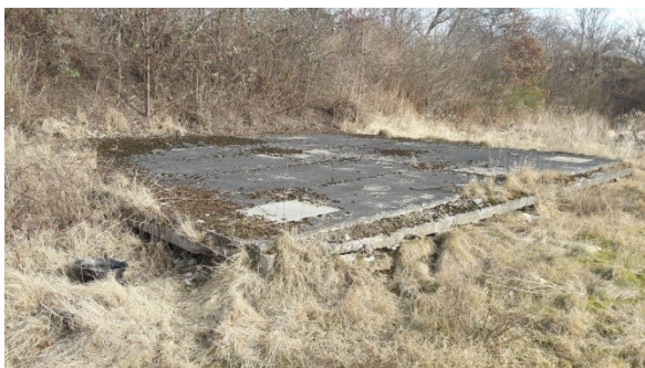
Billede 18. Det gamle betonbassin
