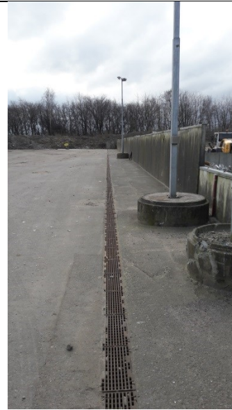
Billede 43. Afvanding fra jordkarteringspladsen
