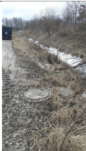
Billede 38. Olieudskillere ved overfladevandsgrøften for vand fra jordkarteringspladsen og sorteringspladsen – beliggende vest for sorteringspladsen.
