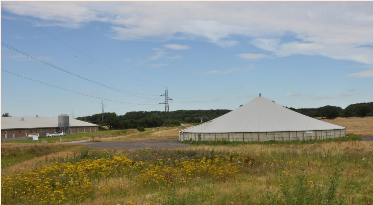
Foto af Pavegyden 1a, set syd fra, fra Højbjergvej, med den eksisterende gyllebeholder til højre, den østlige stald til venstre og højspændingsmast i midten.
