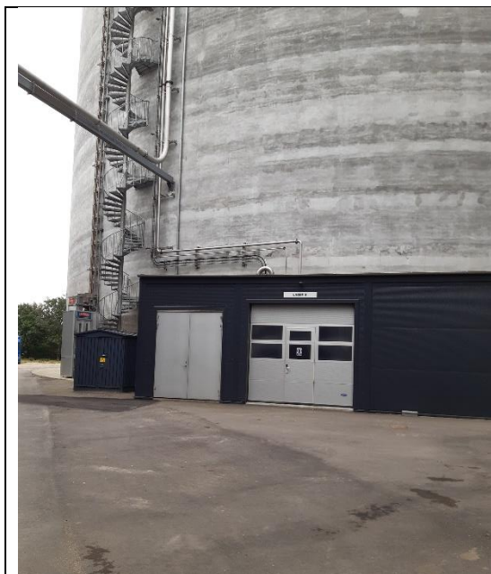
Foto 1: Lager 8, der i tilfælde af brand vil blive slukket af brandslukningsanlæg 1. Oplag af skumprodukt findes i eltavle-rummet bag de to stældøre.
