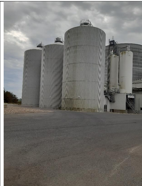
Foto 5: De 3 protein siloer, der i tilfælde af brand vil blive slukke af brandslukningsanlæg 2.
